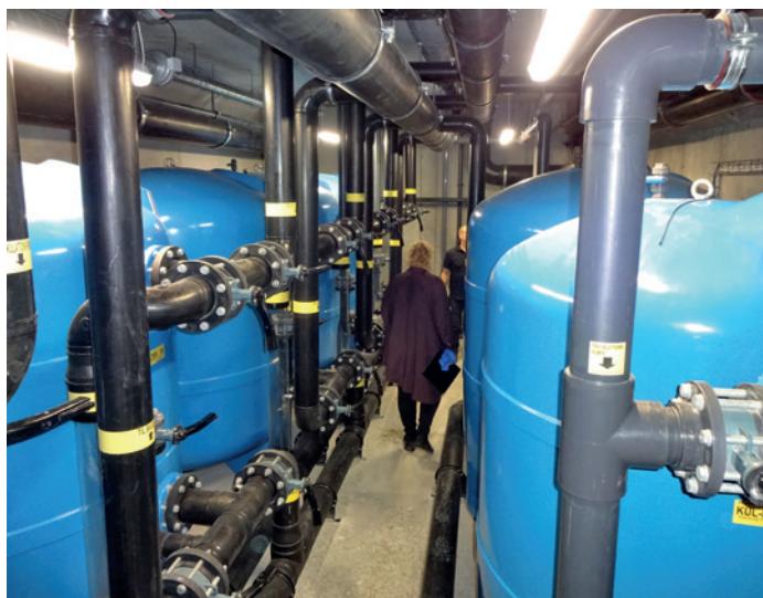
Tilsyn med tankanlægget under Vestbadets bassiner. Foto: Sebastian M. Rasmussen
